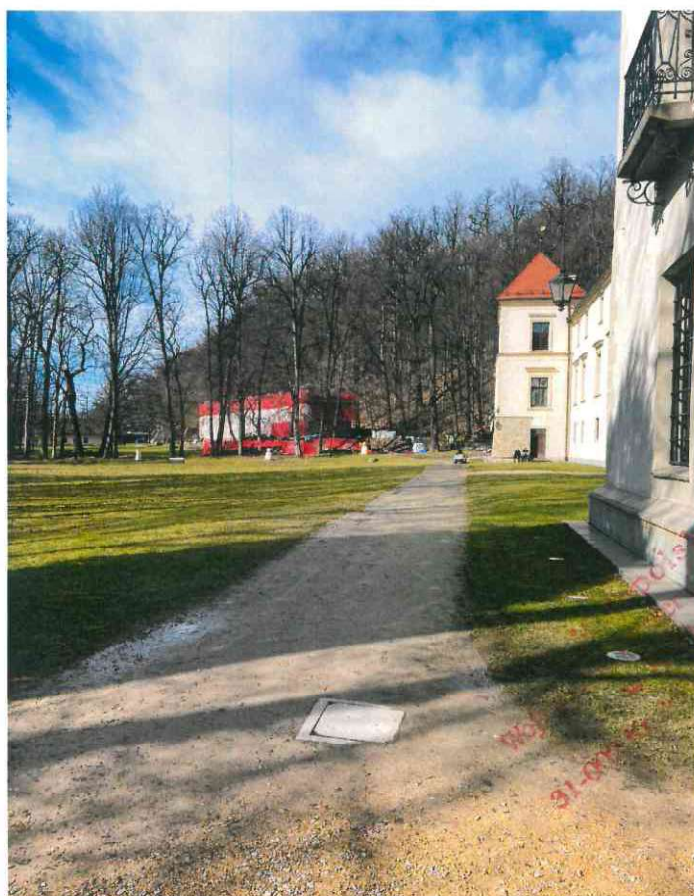
Fot. 3 – Widok ścieżki wzdłuż południowej elewacji zamku.
