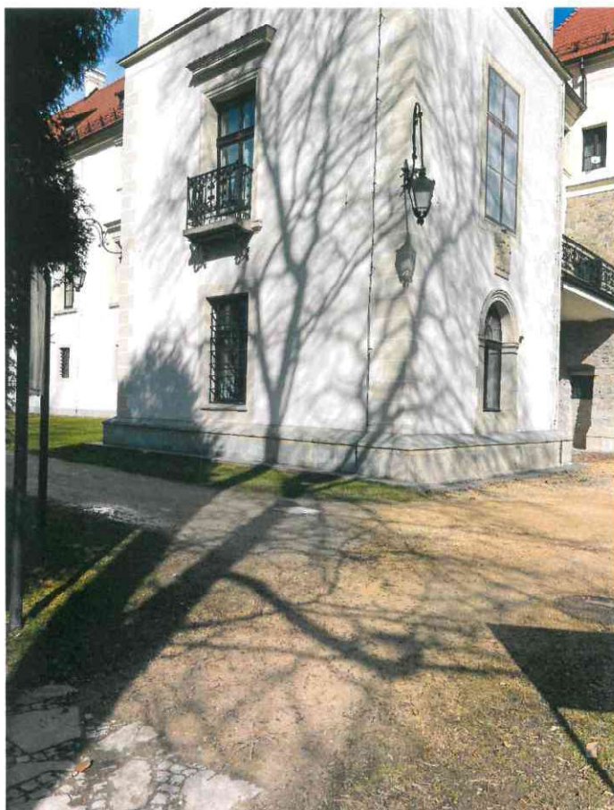
Fot. 2 – Narożnik południowo – wschodni i połączenie z istniejącą ścieżką z płyt i kostki granitowej
