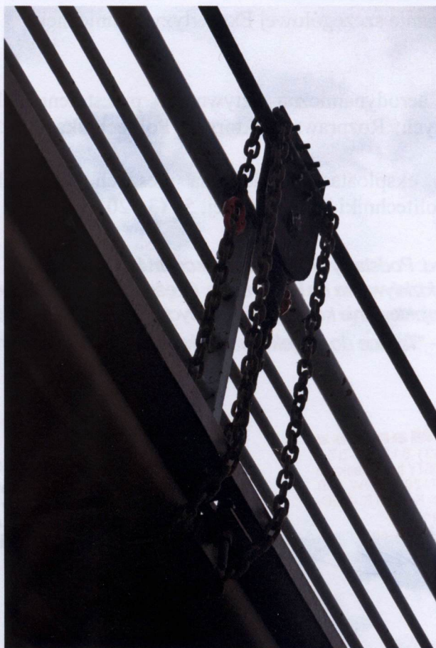
Zdj. Nr 2 – tymczasowa naprawa – pęknięty wieszak prętowy zastąpiono łańcuchem, który spięto przy pomocy szekli.
