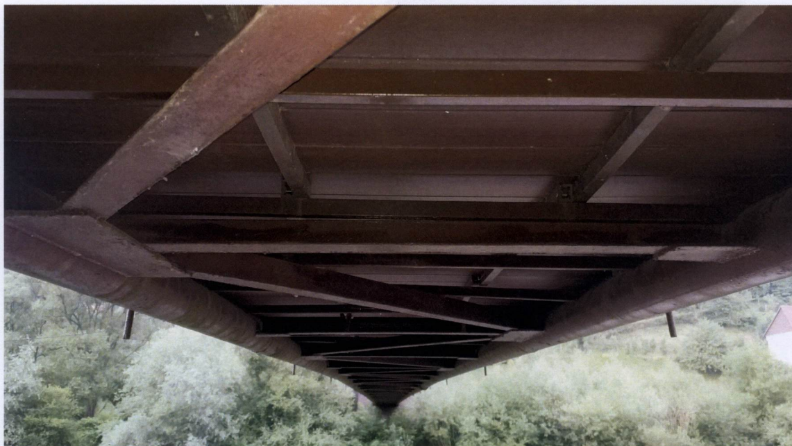
Zdj. Nr 5 – konstrukcja stalowa pomostu – podłużnice profile rurowe oraz stężenia profile z kątowników (słupki, krzyżulce).
