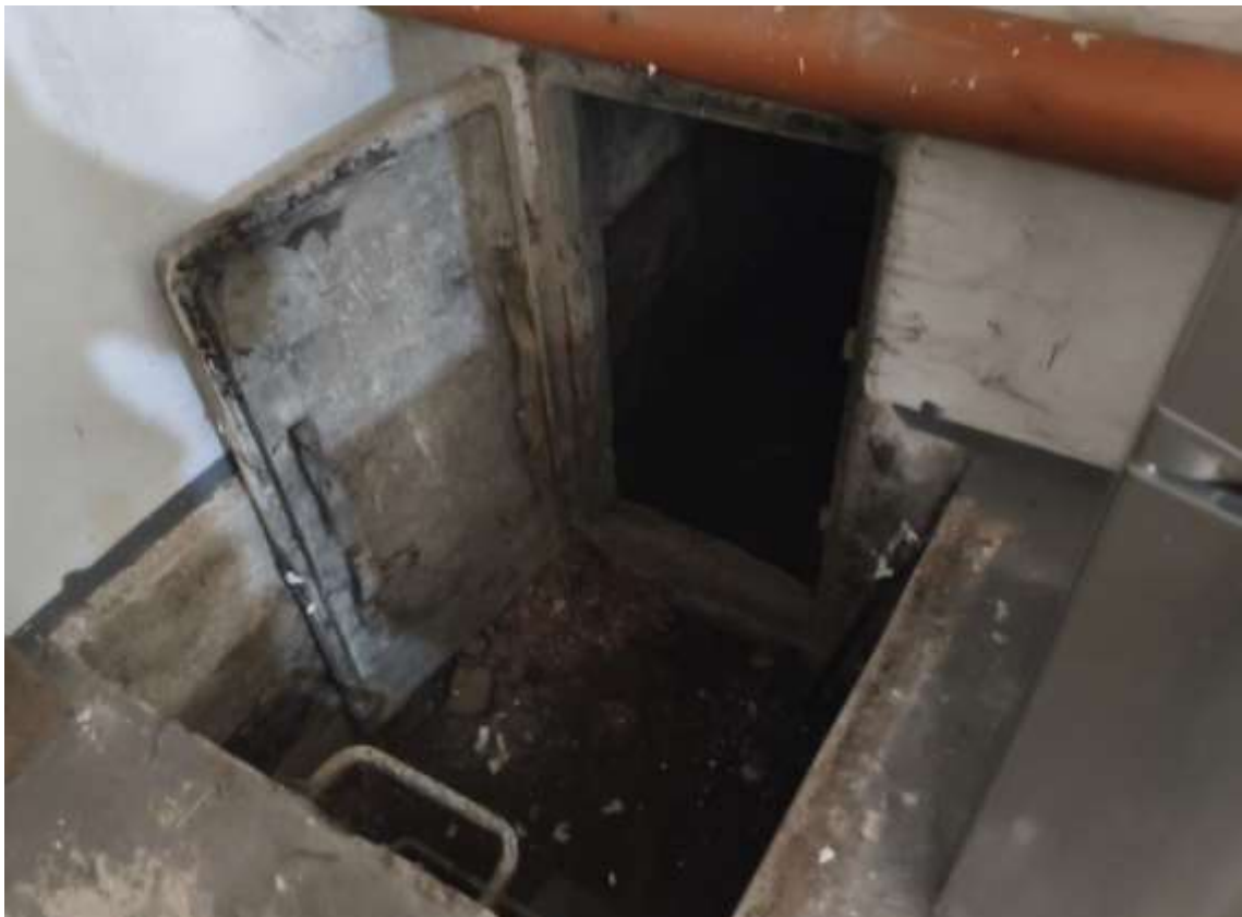
Fotogram nr 27 - Drzwi do tunelu wyjścia zapasowego. – Źródło: zdjęcia własne z wizji lokalnej.
