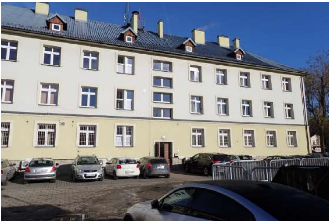
Fotogram nr. 6 – Budynek Urzędu Miasta Suchej Beskidzkiej w którym znajduje się przedmiotowe podpiwniczenie. Widok od strony południowej. – Źródło: zdjęcia własne z wizji lokalnej.
