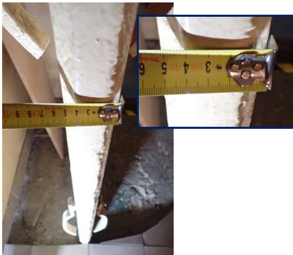
Fotogram nr 36 – Pomiar grubości drzwi wejściowych. – Źródło: zdjęcia własne z wizji lokalnej.
