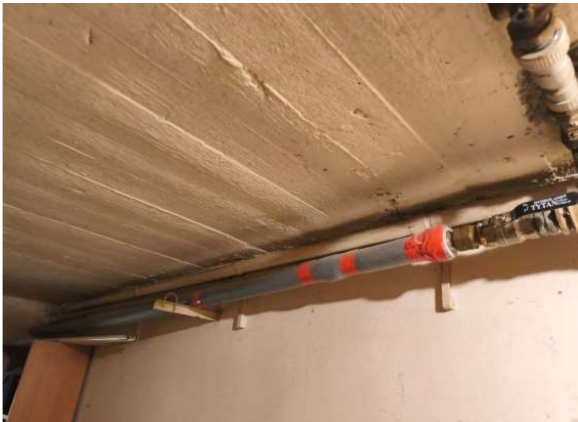
Fotogram nr 32 - Niezabezpieczone instalacje przechodzące przez przegrody budowli ochronnej. – Źródło: zdjęcia własne z wizji lokalnej.
