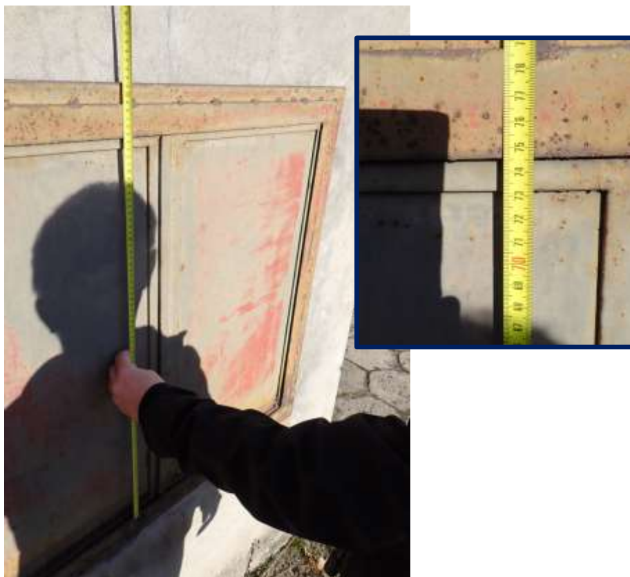
Fotogram nr 35 – Pomiar wysokości wyjścia awaryjnego. – Źródło: zdjęcia własne z wizji lokalnej.
