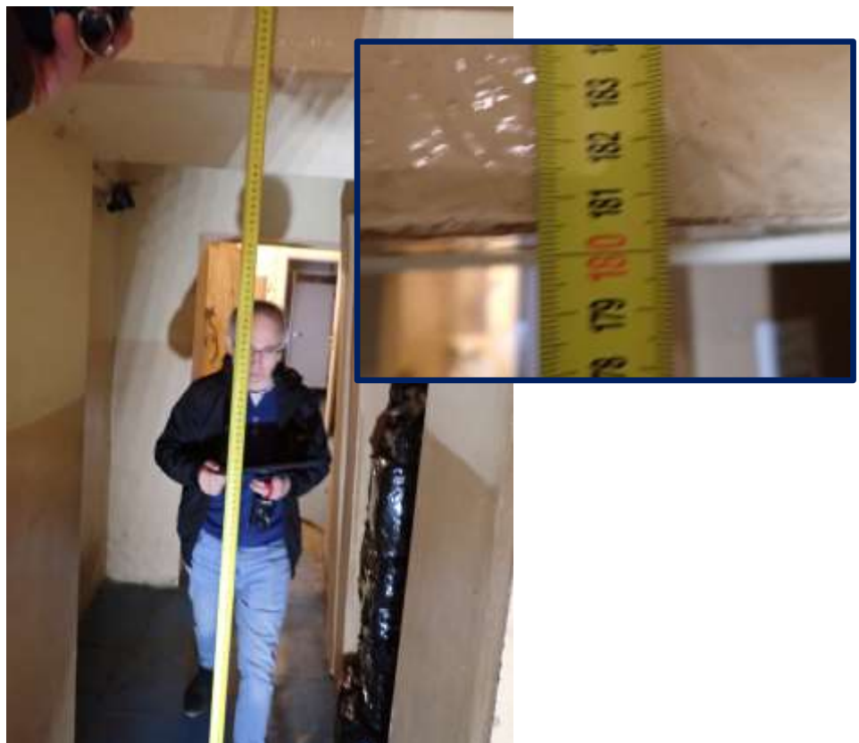
Fotogram nr 38 – Pomiar wysokości otworu wejściowego. – Źródło: zdjęcia własne z wizji lokalnej.
