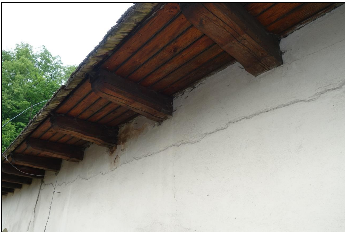
Fot. 15. DOM OGRODNIKA W ZESPOLE ZAMKOWO- PARKOWYM W SUCHEJ BESKIDZKIEJ Stan przed konserwacją, fragment górnej części ściany zach. Widoczne rozległe zniszczenia tynków. Czerwiec 2021 r.
