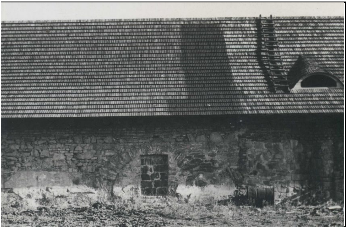
Widok na odsłoniętą pierwotną strukturę muru obiektu gospodarczego z wyraźnym łukiem arkadowym w zarysie ściany – zapewne dawny wjazd do środka, ściany wykonane z nieregularnych ciosów kamienia piaskowca, lata 70. te XX w. Fotografia archiwalna ze zbiorów Muzeum Miejskiego w Suchej Beskidzkiej (syg. F00198).
