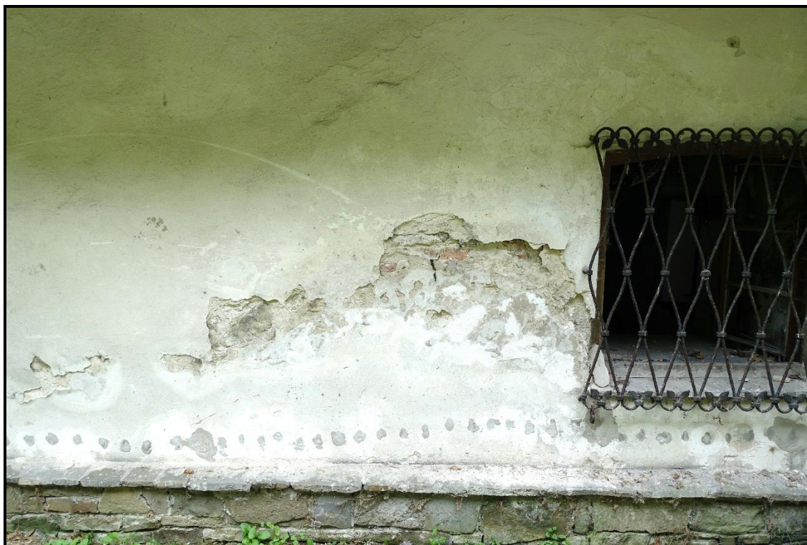
Fot. 18. DOM OGRODNIKA W ZESPOLE ZAMKOWO- PARKOWYM W SUCHEJ BESKIDZKIEJ Stan przed konserwacją, fragment dolnej części ściany płu. Widoczne rozległe zniszczenia tynków.
