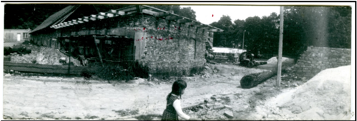
Prace budowlane przy scalaniu dwóch budynków w jeden budynek jednotraktowy, lata 70. te XX w. Fotografia archiwalna ze zbiorów Muzeum Miejskiego w Suchej Beskidzkiej (syg. F DP-1969-108-1).
