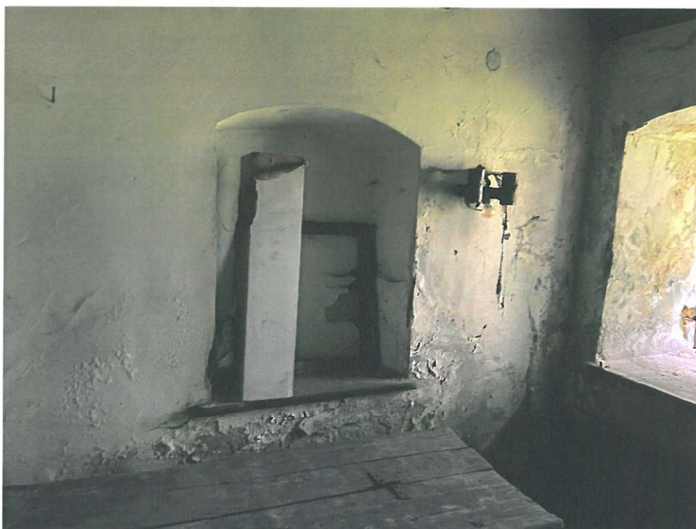
zawilgocenie ścian
