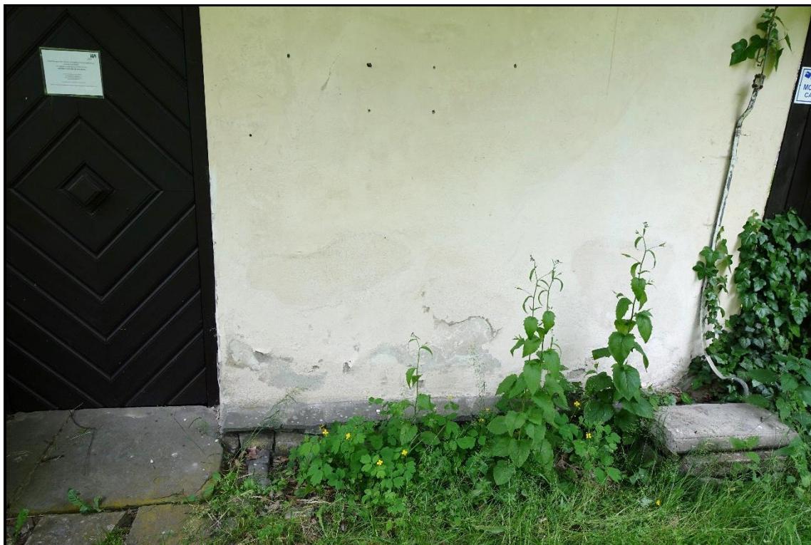
Fot. 7. DOM OGRODNIKA W ZESPOLE ZAMKOWO- PARKOWYM W SUCHEJ BESKIDZKIEJ Stan przed konserwacją, fragment dolnej części elewacji wsch. Widoczne rozległe zniszczenia tynków. Czerwiec 2021 r.
