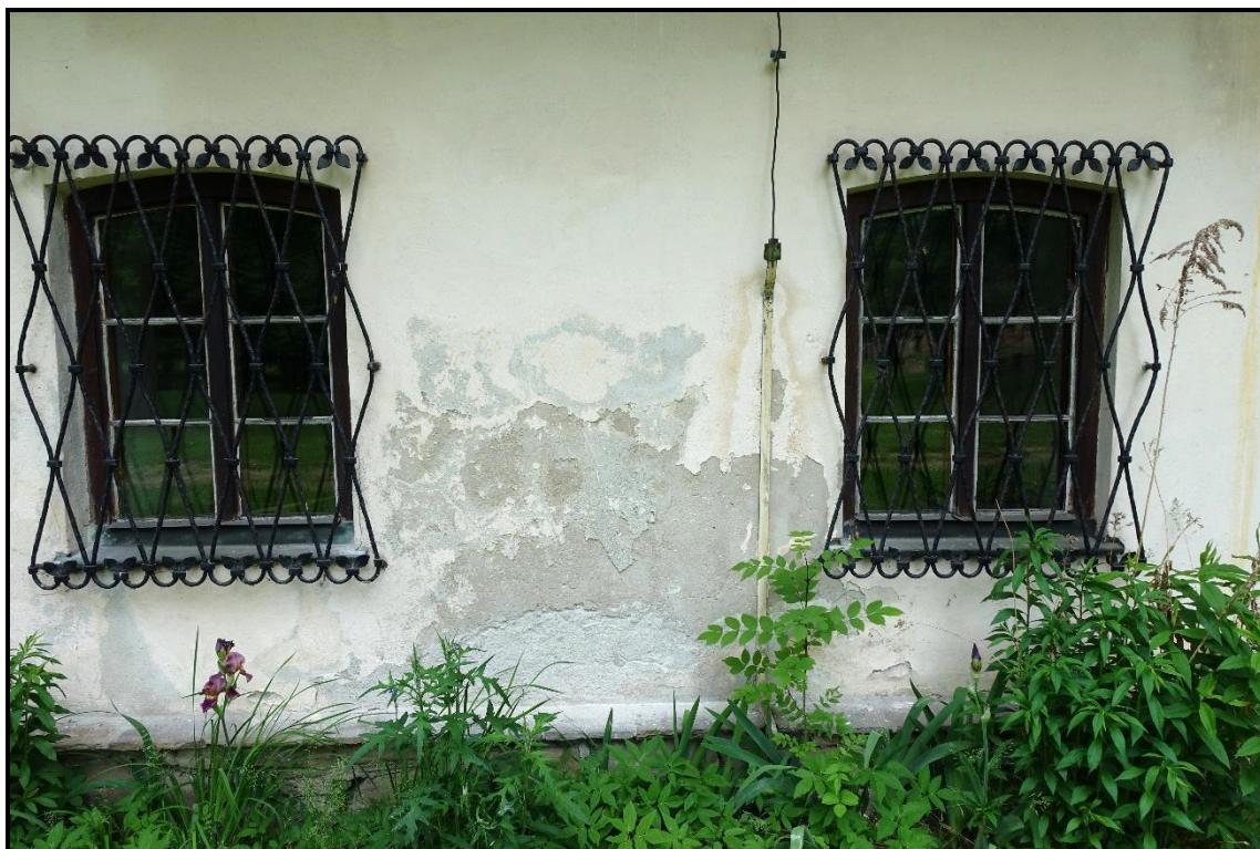
Fot. 6. DOM OGRODNIKA W ZESPOLE ZAMKOWO- PARKOWYM W SUCHEJ BESKIDZKIEJ Stan przed konserwacją, fragment dolnej części elewacji wsch. Widoczne rozległe zniszczenia tynków.
