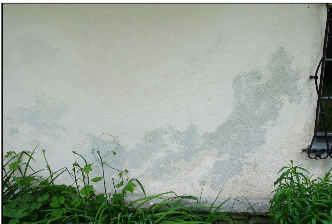
Fot. 8. DOM OGRODNIKA W ZESPOLE ZAMKOWO- PARKOWYM W SUCHEJ BESKIDZKIEJ Stan przed konserwacją, fragment dolnej części elewacji wsch. Widoczne rozległe zniszczenia tynków. Czerwiec 2021 r.
