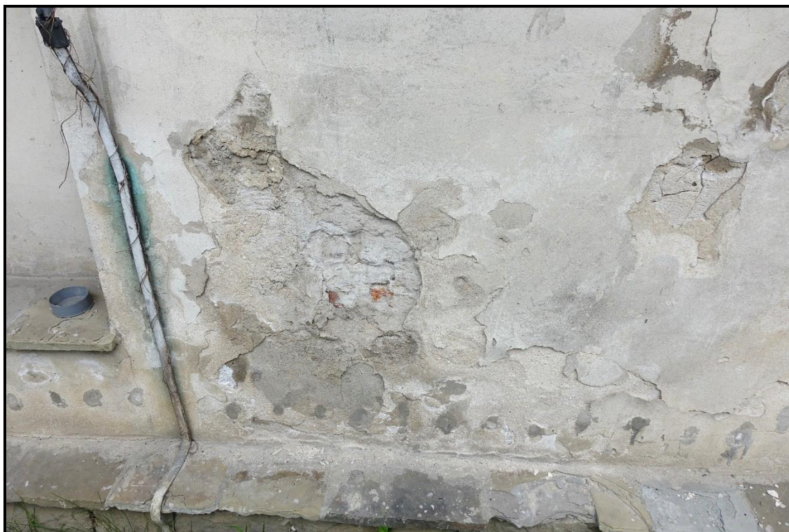
Fot. 14. DOM OGRODNIKA W ZESPOLE ZAMKOWO- PARKOWYM W SUCHEJ BESKIDZKIEJ Stan przed konserwacją, fragment dolnej części elewacji zach. Widoczne rozległe zniszczenia tynków. Czerwiec 2021 r.
