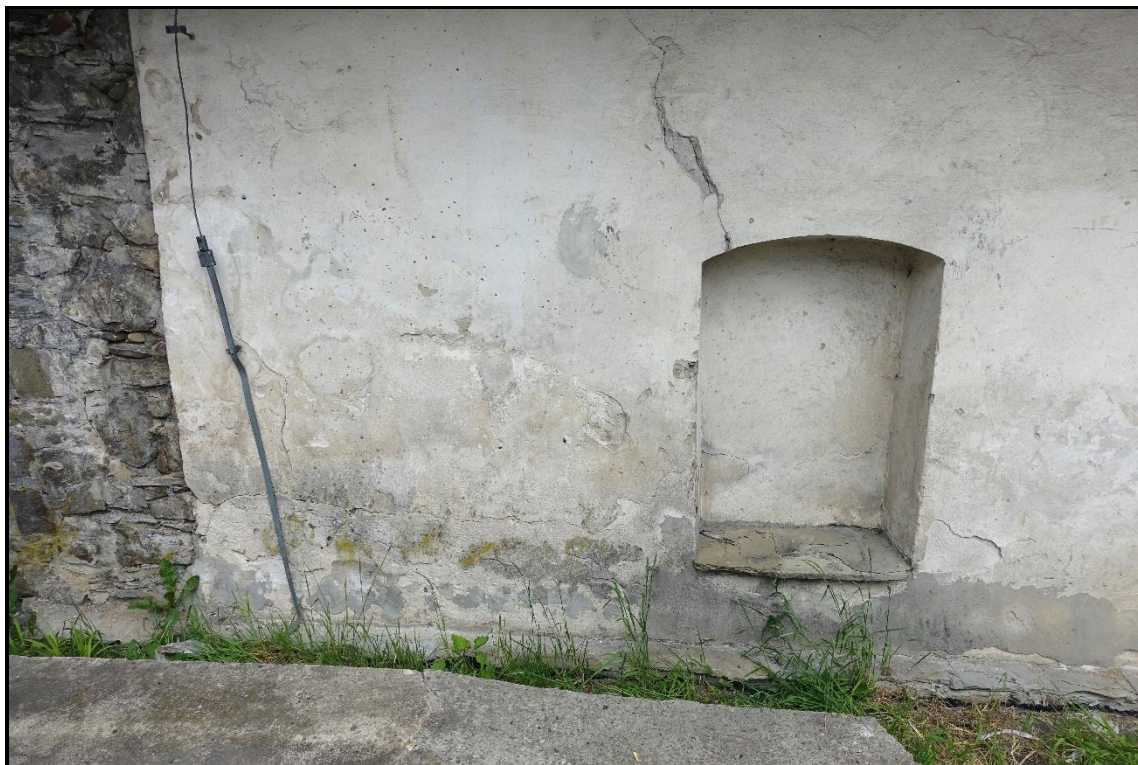
Fot. 13. DOM OGRODNIKA W ZESPOLE ZAMKOWO- PARKOWYM W SUCHEJ BESKIDZKIEJ Stan przed konserwacją, fragment dolnej części elewacji zach. Widoczne rozległe zniszczenia tynków. Czerwiec 2021 r.
