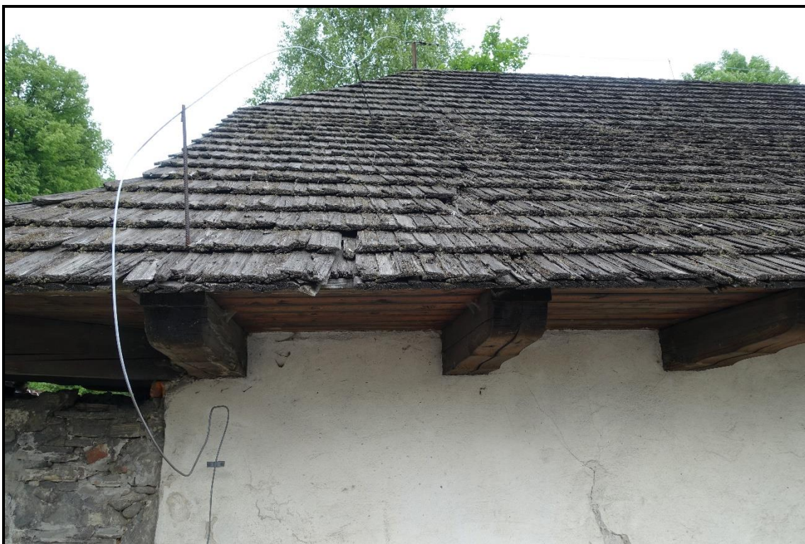
Fot. 16. DOM OGRODNIKA W ZESPOLE ZAMKOWO- PARKOWYM W SUCHEJ BESKIDZKIEJ Stan przed konserwacją, fragment części ściany zach. z dachem. Widoczne rozległe zniszczenia tynków. Czerwiec 2021 r.
