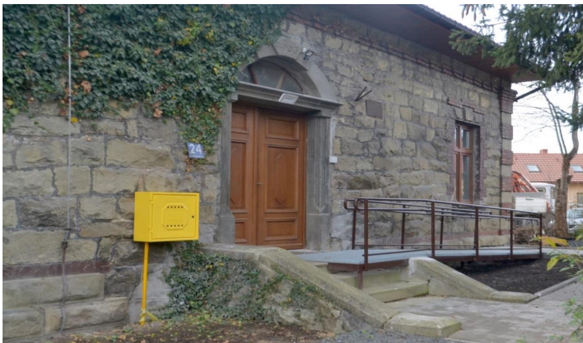
Zdjęcia nr 7. Budynek przy ul. Makowskiej 24
