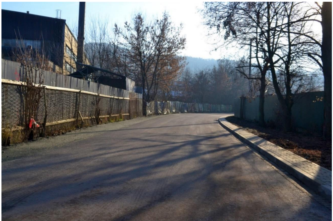
Zdjęcie nr 9 i 10. Ulica Kolejowa przed i po przeprowadzonej modernizacji
