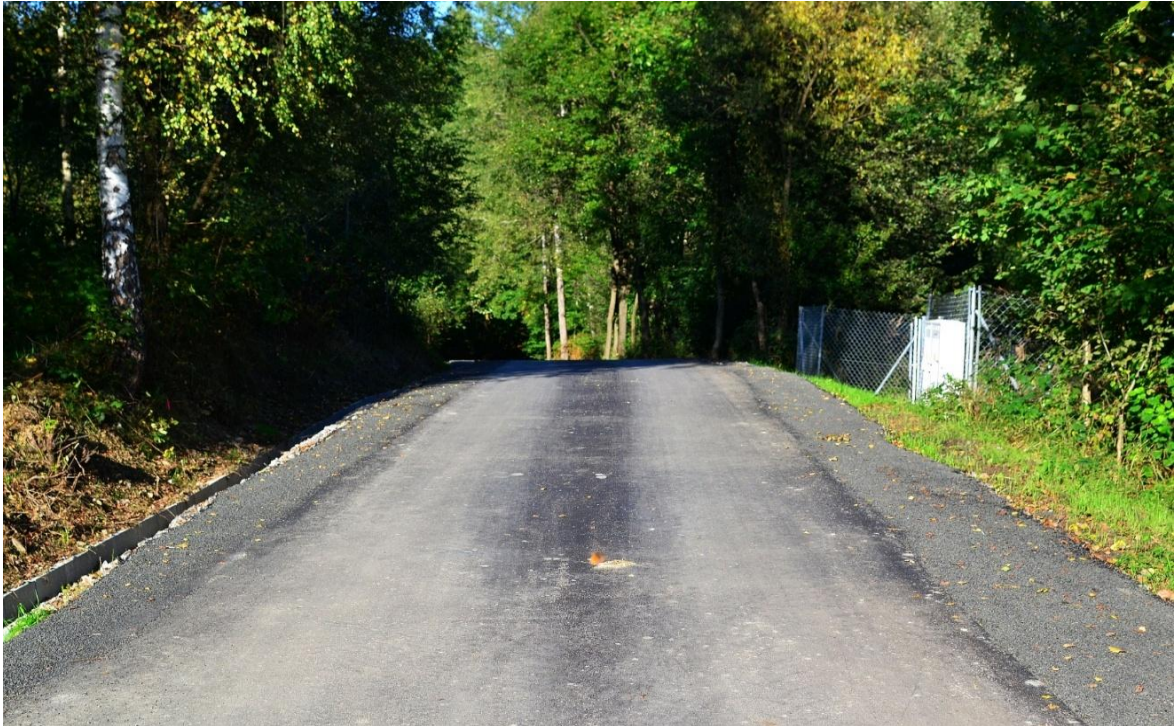
Zdjęcie nr 5. ul. Sosnowa po remoncie
