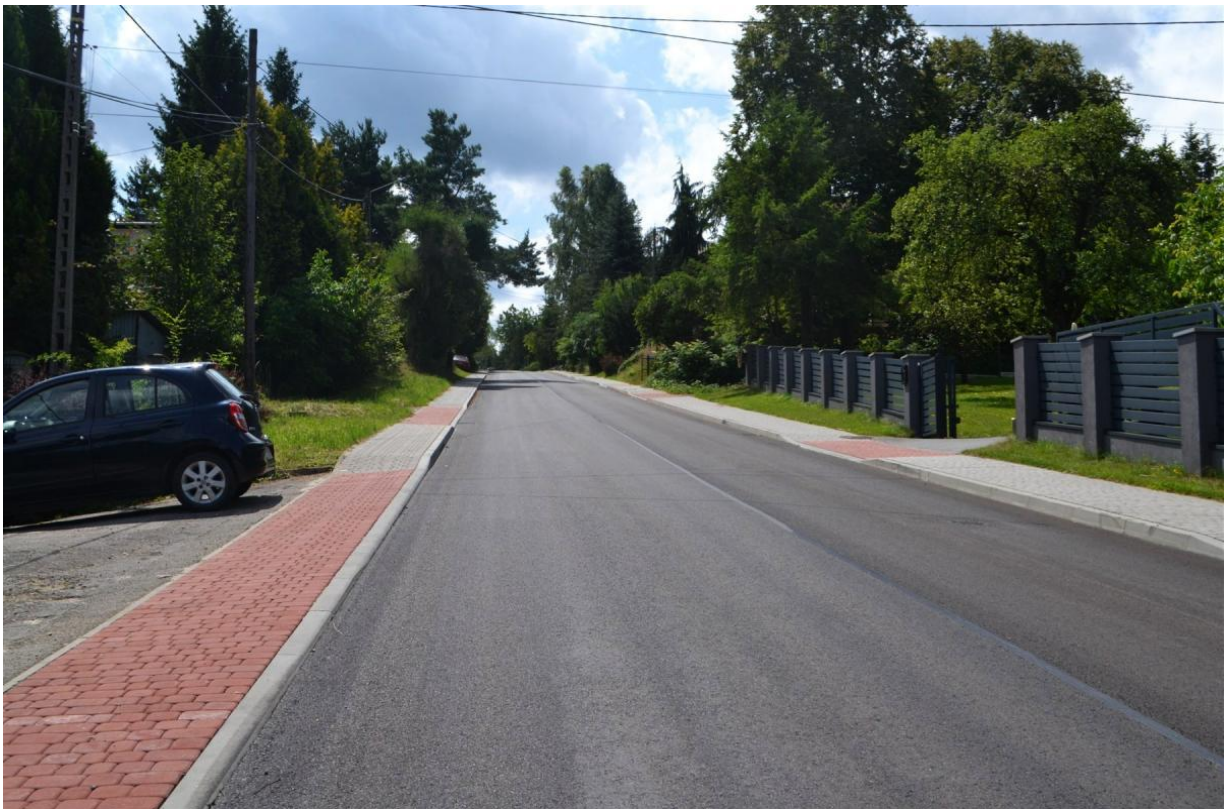
Zdjęcie nr 4. ul. 3 Maja po remoncie
