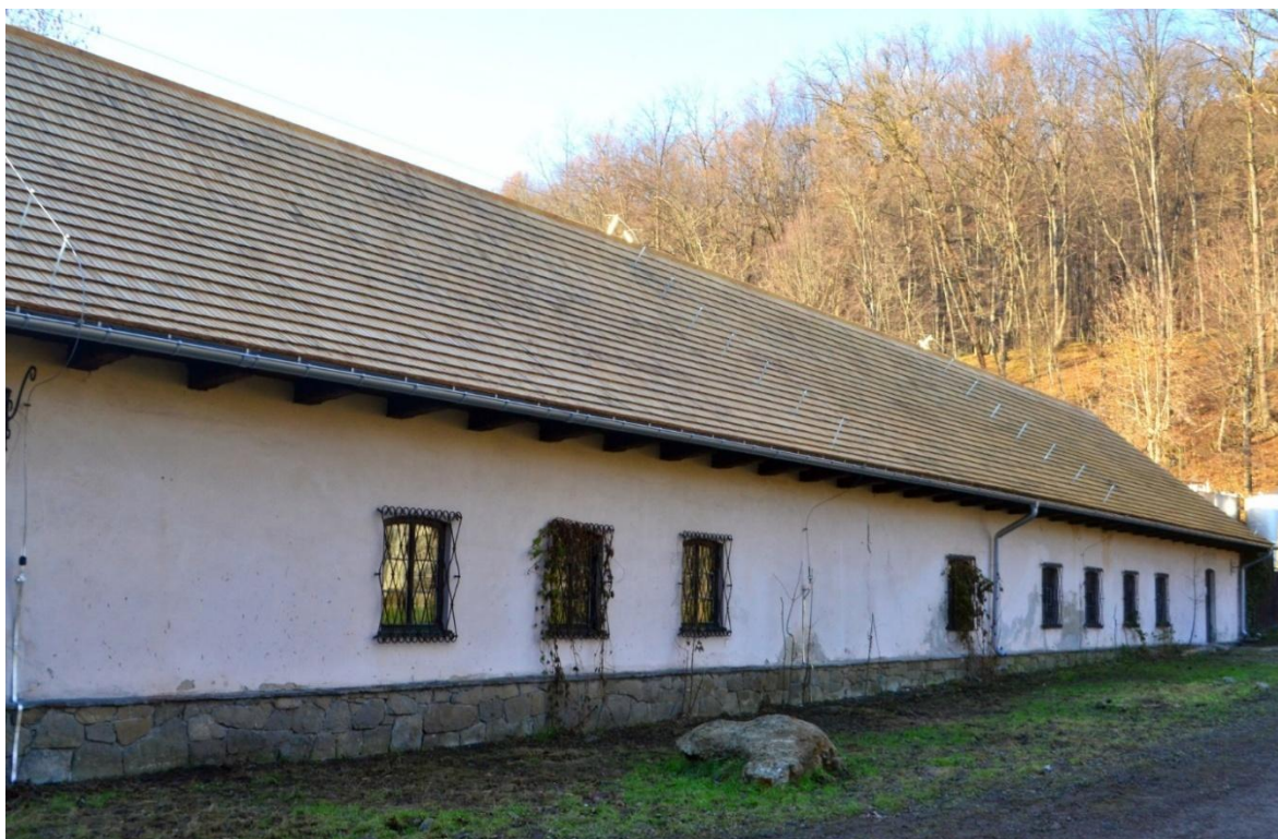
Zdjęcie nr 3. Domek ogrodnika z nowym pokryciem dachowym (podwójny gont)
