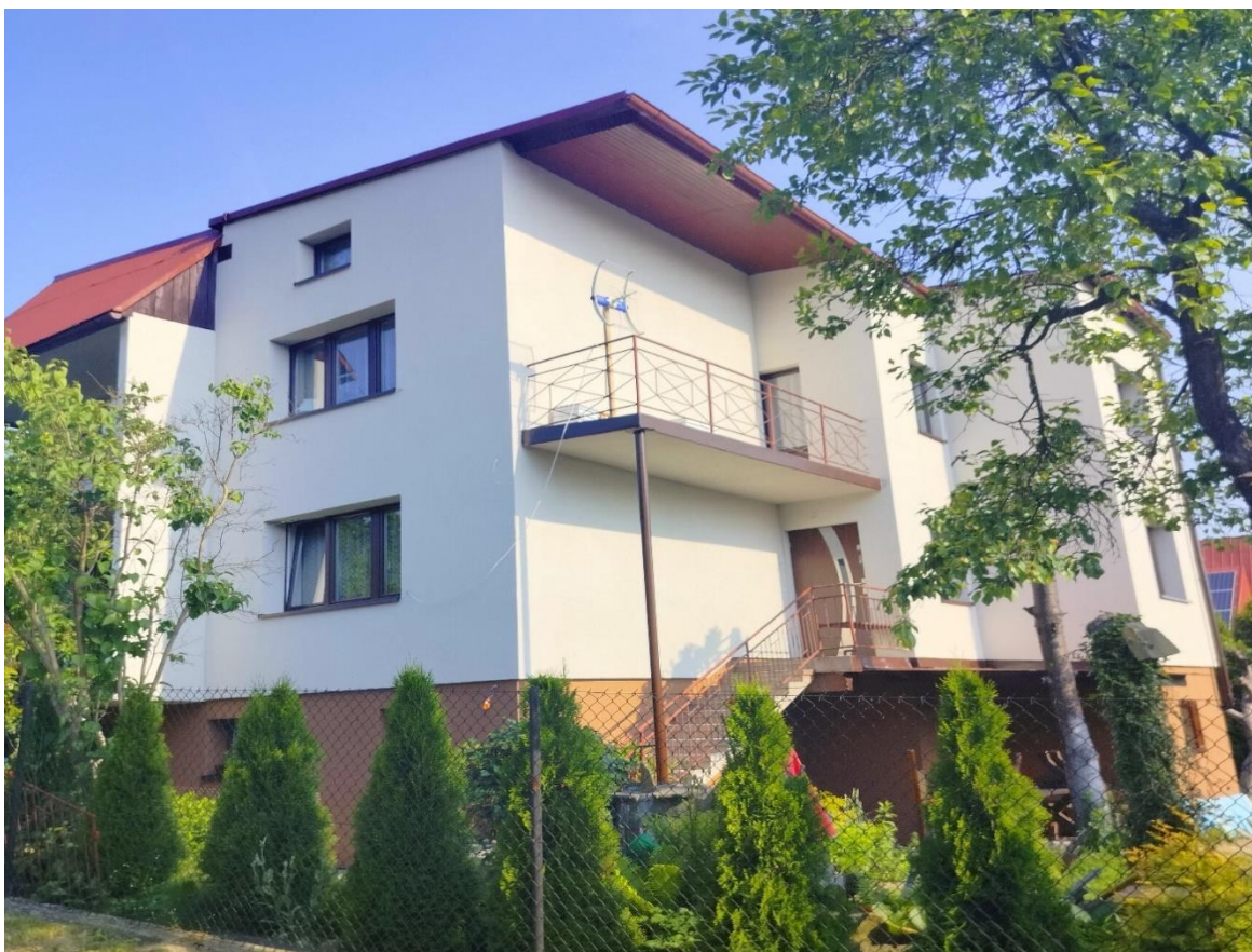
Zdjęcie nr 1. Budynek przy ul. 3 Maja po termomodernizacji
