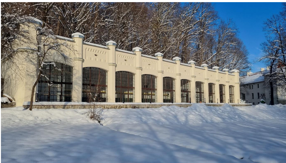
Zdjęcie nr 5. Oranżeria po odbudowie i renowacji – grudzień 2023 rok
