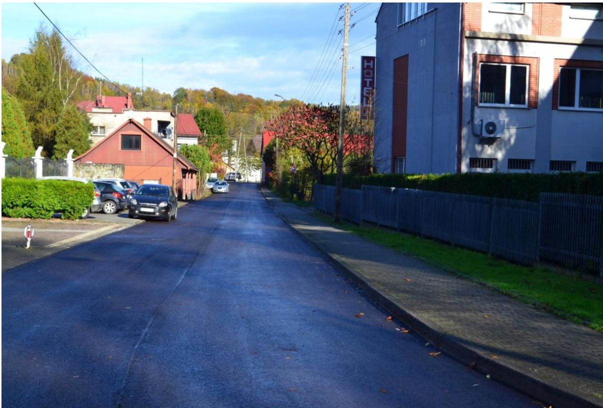
Zdjęcie nr 9. ul. Spółdzielców po remoncie
