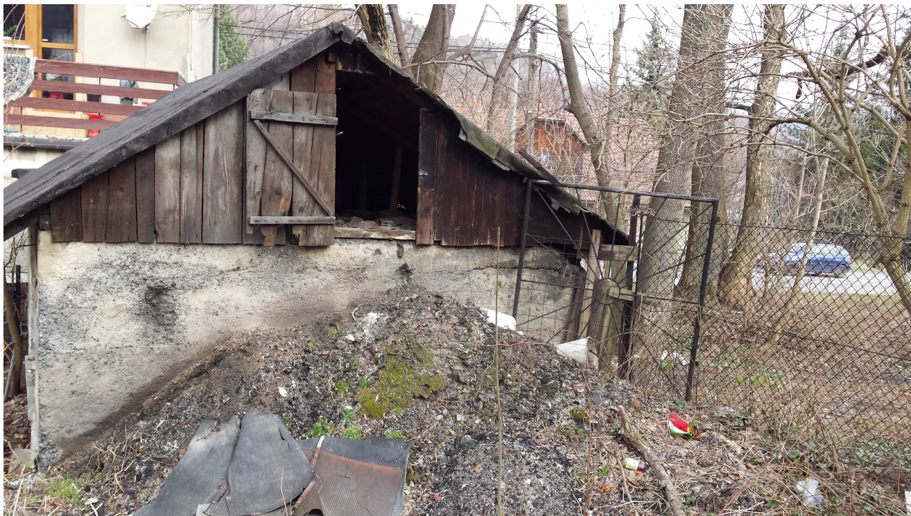
WIDOK OD STRONY POŁUDNIOWEJ
