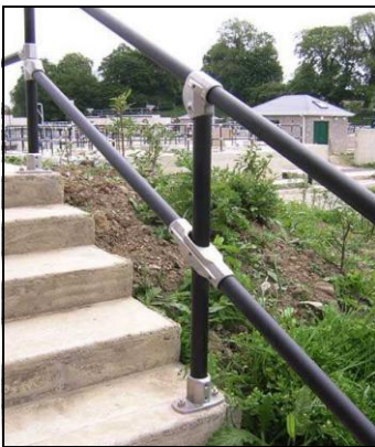
Fot. 11 Przykład wykonania balustrady bezpieczeństwa w systemie ze złączkami żeliwnymi
