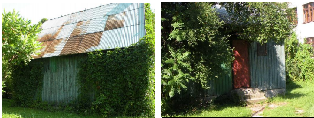
Fot. 14 Widok domku letniskowego przewidzianego do rozbiórki
