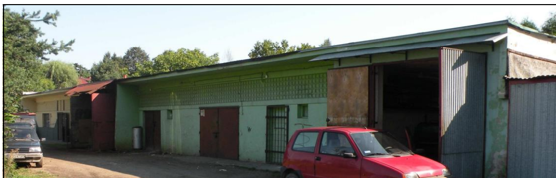
Fot. 13 Widok budynków magazynowych przewidzianych do rozbiórki
