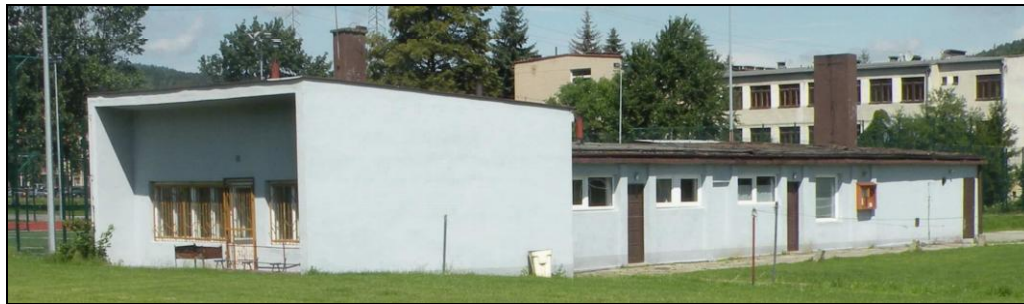
Fot. 12 Widok budynku zaplecza sportowego przewidzianego do rozbiórki
