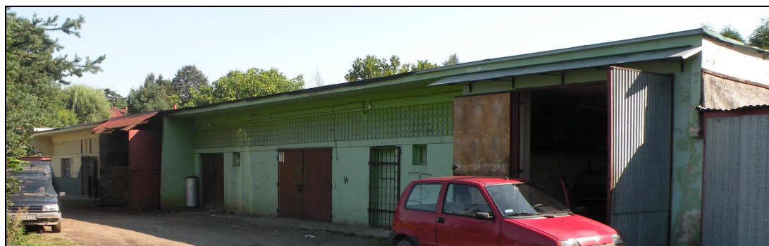
Fot. 13 Widok budynków magazynowych przewidzianych do rozbiórki
