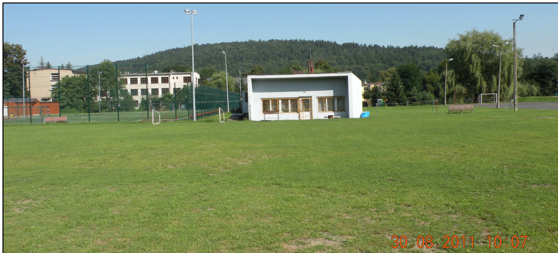
FOT. 6 Widok istniejącego treningowego boiska piłkarskiego n murawą naturalną, widok zaplecza sportowego, po lewej stronie widok kompleksu boisk Orlik 2012
