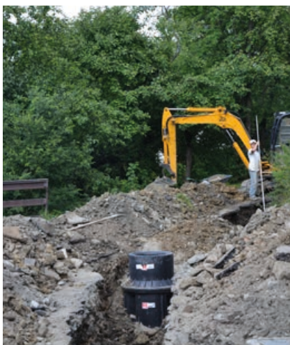
Budowa kanalizacji na os. Garce
