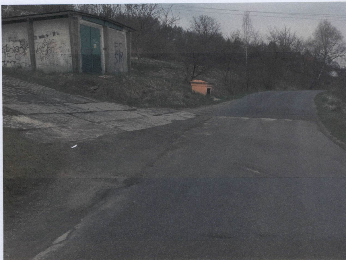
Fot. 2. Widok na koniec odcinka drogi gminnej objętej opracowaniem (skrzyżowanie z inną drogą gminną wewnętrzną)
